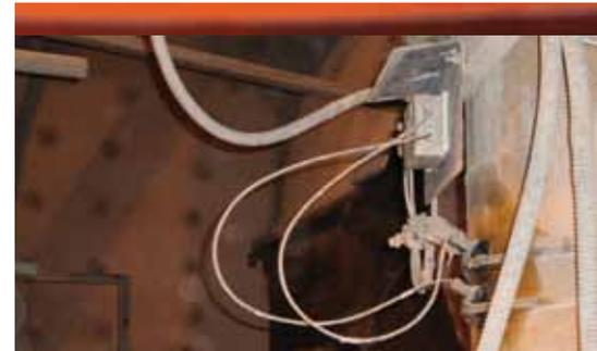
Al norte de Chile, Codelco Chuquicamata, tuvo la necesidad de medir el flujo en tuberías por donde pasa pulpa mineral. Los diámetros de estas tuberías son de entre 12 y 24 pulgadas, fabricadas en acero con revestimiento interno de goma, esto con el objetivo de reducir la abrasión. El contenido de esta pulpa es de aproximadamente un 70 % de sólidos en suspensión.
